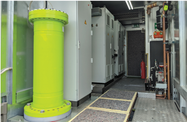
Hochgeschwindigkeits-Schwungradspeicher von Stornetic: Innenansicht der Anlage mit dem Schwungrad (grün), Stromrichter (links) und Kühlsystem (rechts).
